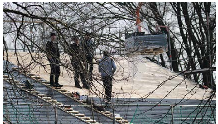
Das Dach vom Athletenzentrum wurde schon neu eingedeckt
